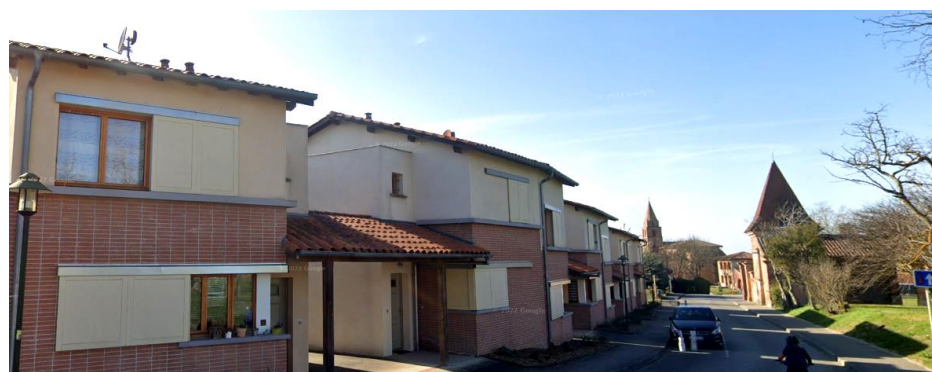
Construction d'habitat récentes bien intégrées au bourg ancien
